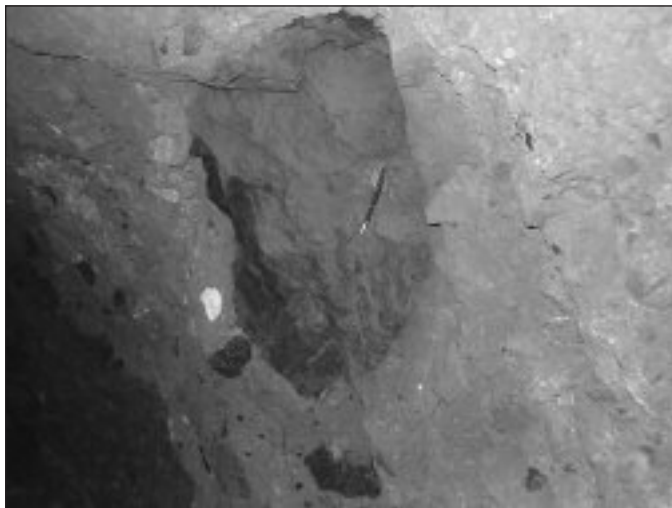
Foto 1. Aspecto del "mortalón" en el interior de una galería, compuesto por una matriz areno-arcillosa que engloba bloques de distintos tamaños y composición diversa
